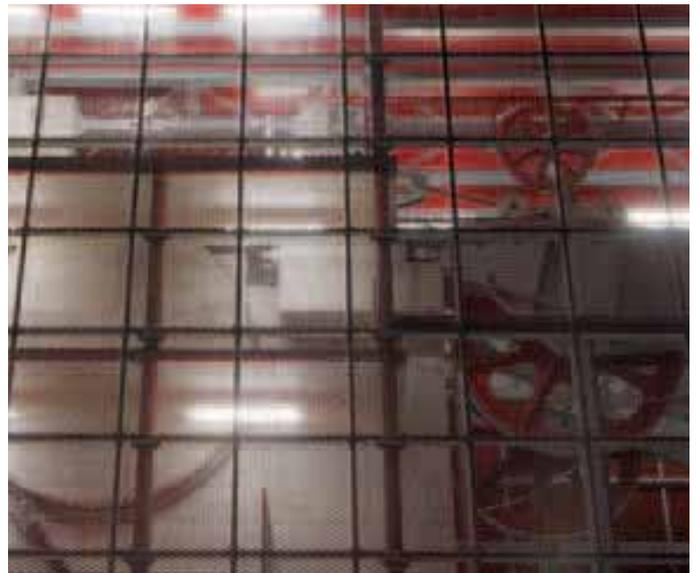
Das Gehäuse der Station und die technischen Räume sind von einem rot lackierten Streckmetall umgeben, das gleichzeitig die Belüftung zu der Räumlichkeiten, ausreichende Beleuchtung und Wetterschutz sicherstellt.
