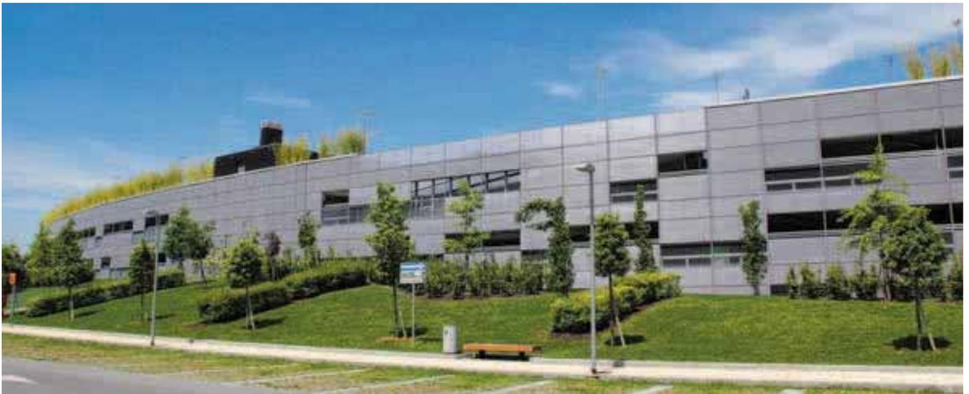
Die Streckmetallverkleidung garantiert die Durchlüftung des mehrgeschossigen Parkhauses. Dem kompakten Gebäude wird durch die Transparenz des Streckgitters seine Schwere genommen.
