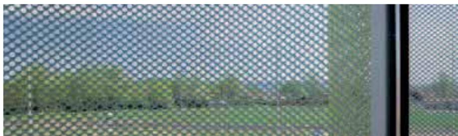
Längliche halbkreisförmige Säulen aus Streckmetall ermöglichen Transparenz und Bewegung in der Fassade. Die Schriftzeichen werden dynamisch auf den Reisen im Schnellzug wahrgenommen.
