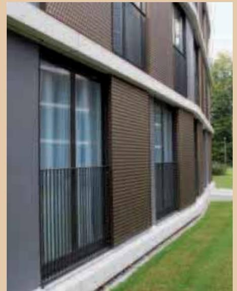
Die verschiebbaren Sonnenschutzelemente können nach Bedarf angeordnet werden und sorgen für einen optimalen thermischen und visuellen Komfort.
