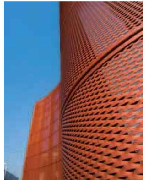
Eine Bühnenkulisse fließend und dynamisch, mit Elementen aus Streckmetall für eine umfassende Sanierung, die den Gebäudecharakter mit der gesamten Fassade in Einklang bringt.
