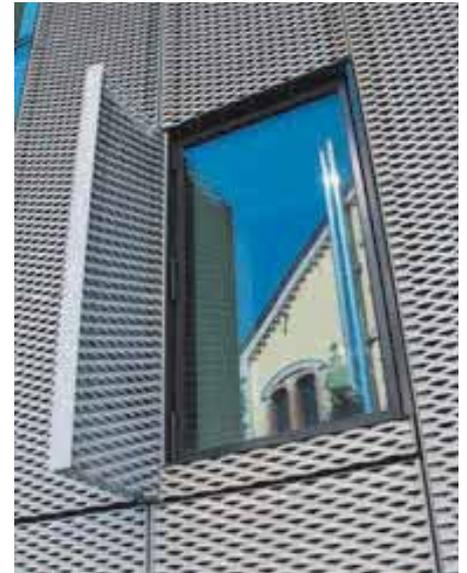
Vertikale Gebäudehülle, horizontale Decke und seitliche "Rippen" als Sonnenschutz an den Fensteröffnungen für einen doppelten Zweck: Verkleidung und Schattierung.
