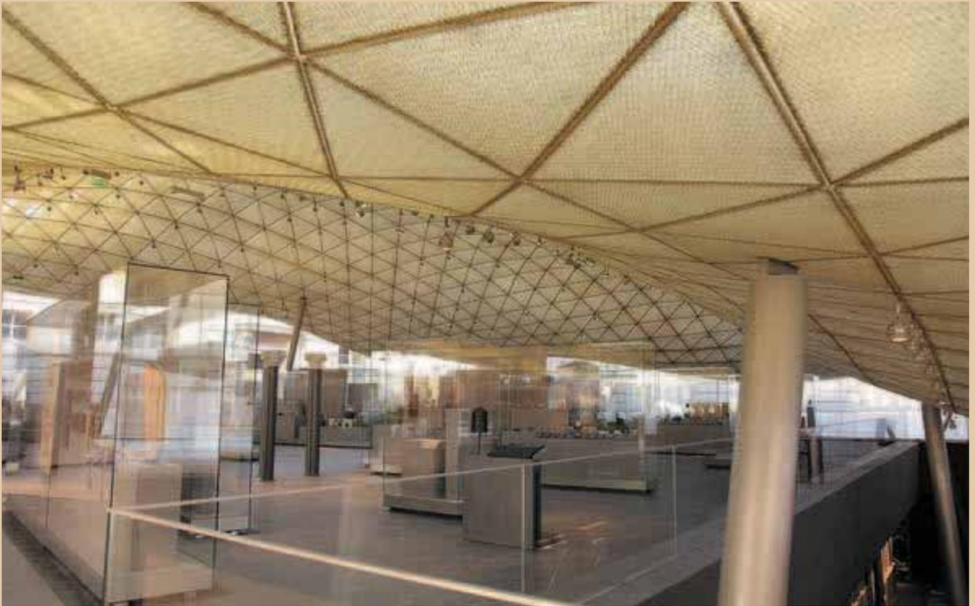
Die einzelnen Elemente sind sowohl auf die Eigenschaften der Materialien und Oberflächen als auch für den mechanischen Widerstand gegen Wind- und Schneelast zertifiziert worden.
