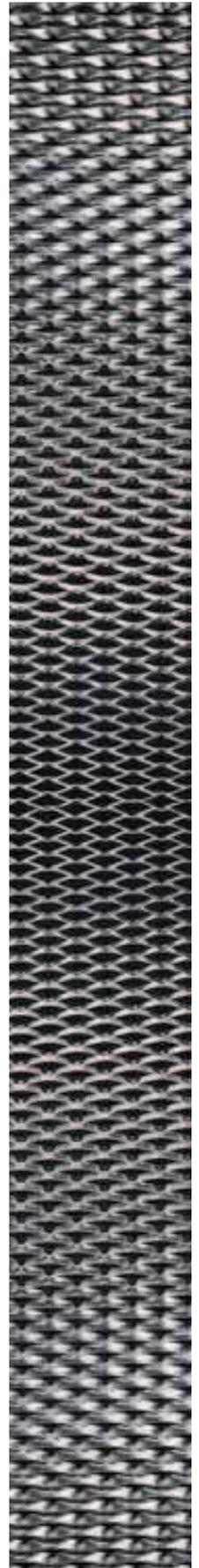
Fassade mit Streckmetallgitter in variabler Öffnung. Effizienter Sonnenschutz stellt die Transparenz sicher und erlaubt eine Kontrolle der Sonnenstrahlung auf den Glaswänden.
